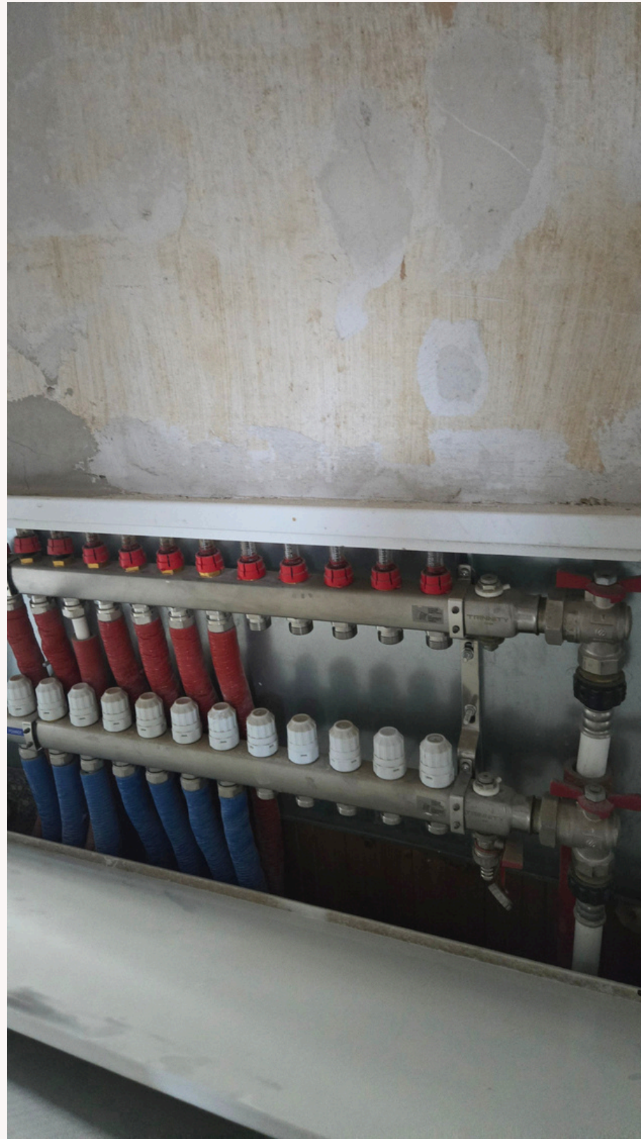
Fußbodenheizung
